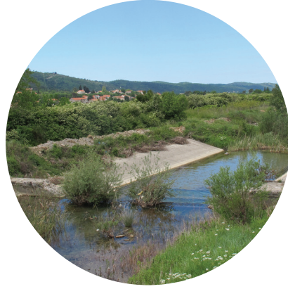
Djelomično kanalizirana rijeka Konavočica The partially channelised river Konavočica
