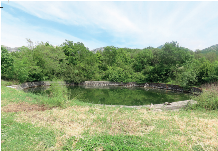
▲ Opasivanje lokve betonom u punom opsegu, Podimoć Full-scale concrete encasement of the pond, Podimoć
